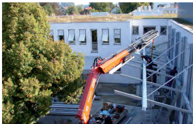
Montage in luftiger Höhe
